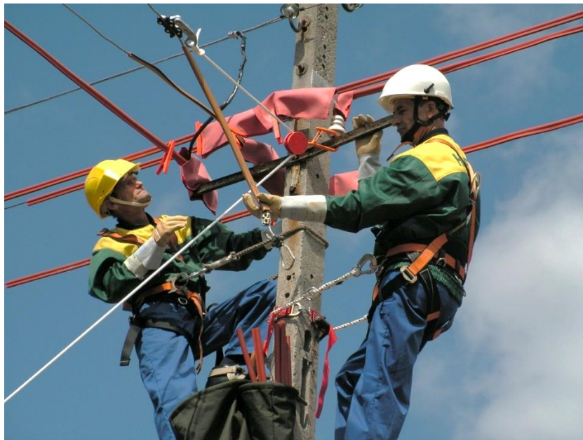
Рис. 1. Выполнение работ под напряжением методом «в контакте»
